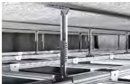
Cielorrasos suspendidos con soporte rígido
