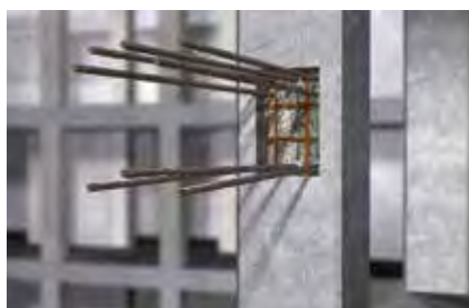
Hierros de construcción
