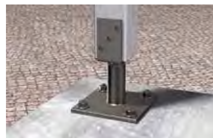
Bases de columnas
